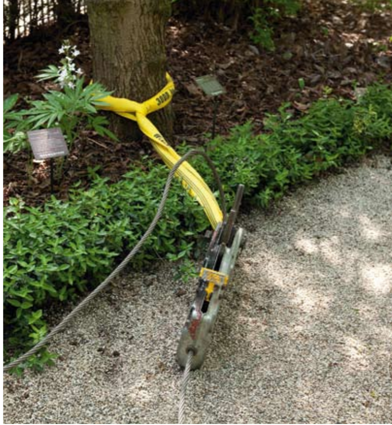
De lier wordt aan een ankerpunt vastgemaakt en de kabel kan op spanning gebracht worden.
